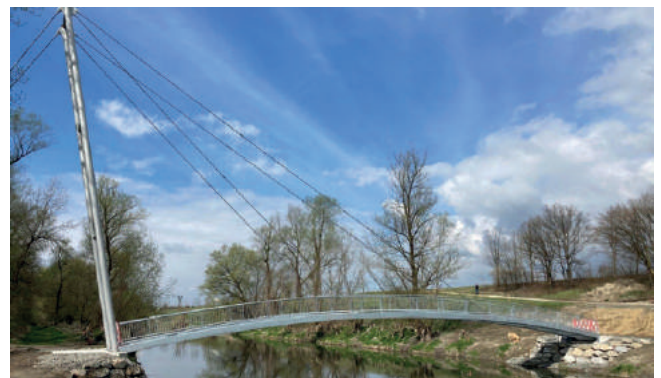
Fußgänger- und Fahrradbrücke über den Innbach in Alkoven, Österreich (Gemeinde Alkoven)
