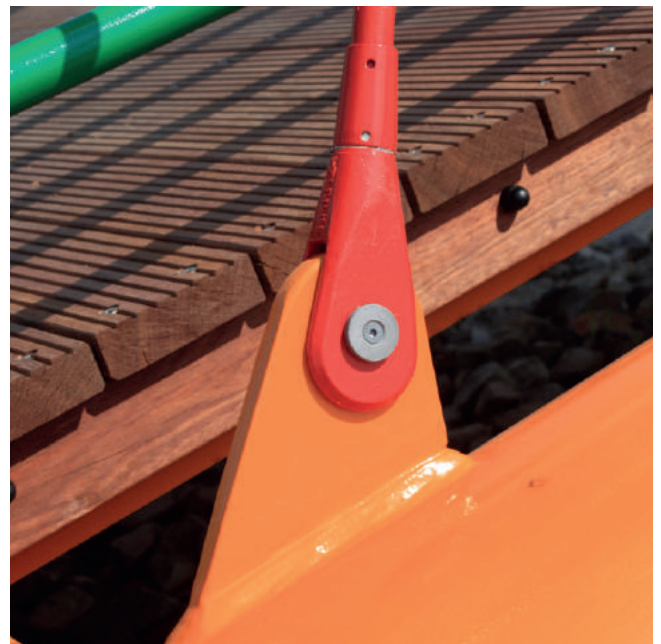
Fußgängerbrücke über die Lagune bei Kluczborc, Polen (Zem Labedy)
