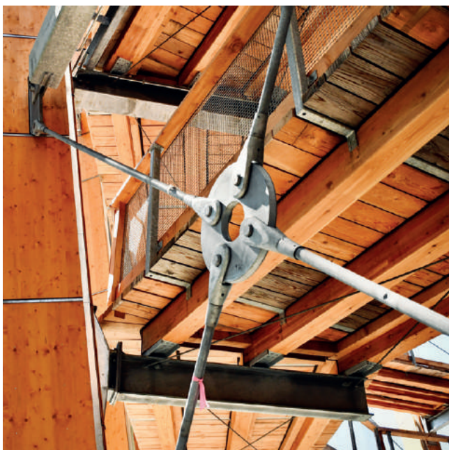
Malahat Skywalk auf Vancouver Island, Kanada (Kinsol Timber Systems)
